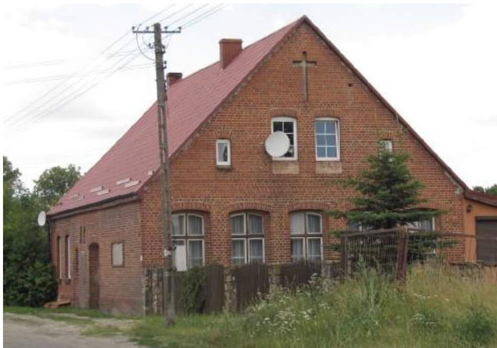
Fot. 1 Widok od strony drogi
