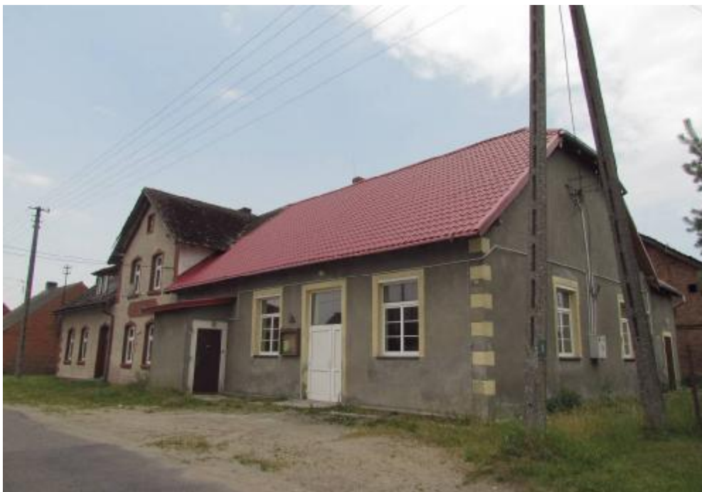
Fot. 1 Widok od strony drogi
