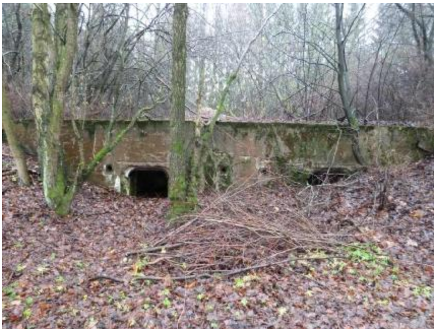
Fot. 1 Pozostałości schronu bojowo – biernego, wejście główne
