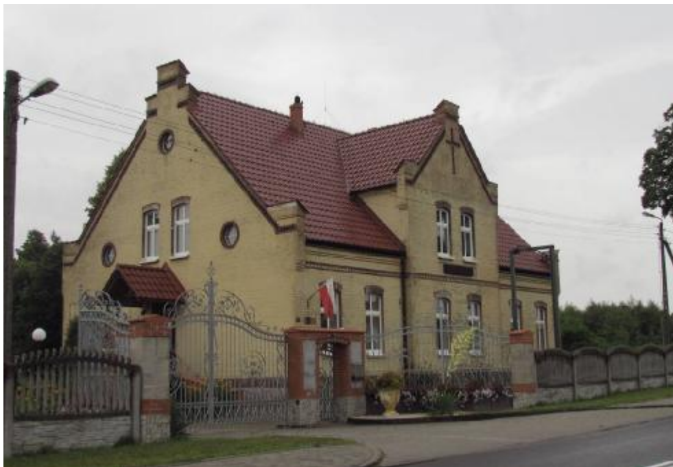
Fot. 1 Widok od strony drogi
