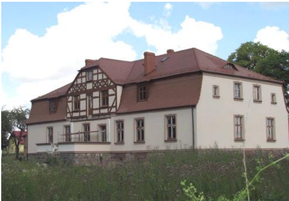
Fot. 1 Widok od strony frontowej
