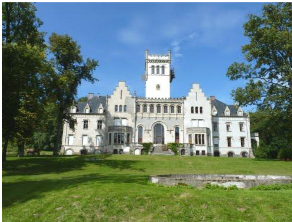
Fot. 2 Widok od strony tarasu
