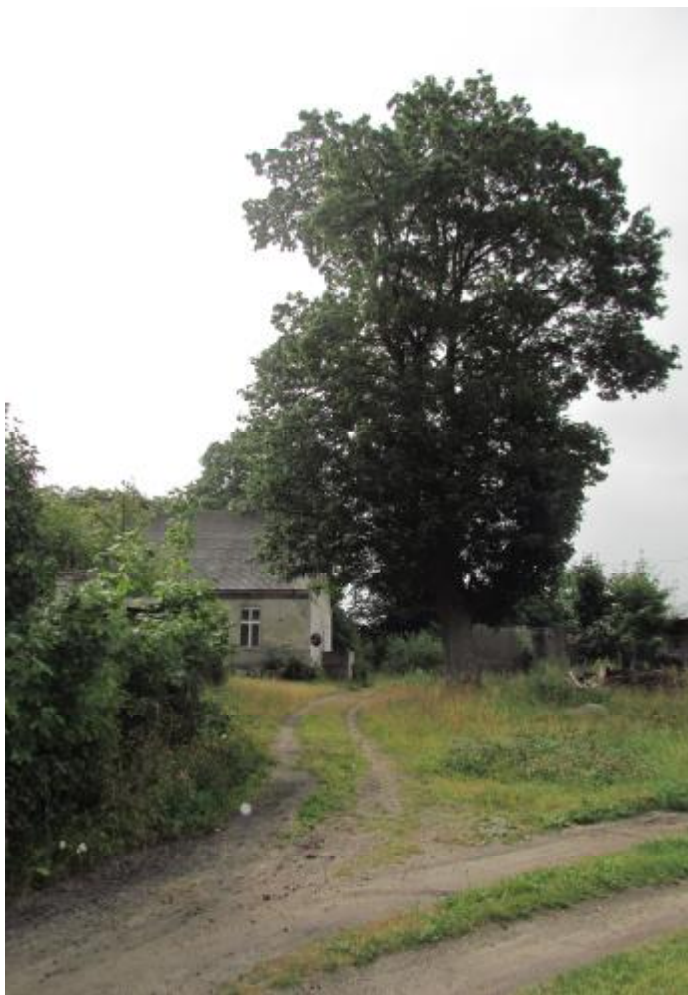
Fot. 1 Widok od strony drogi dojazdowej
