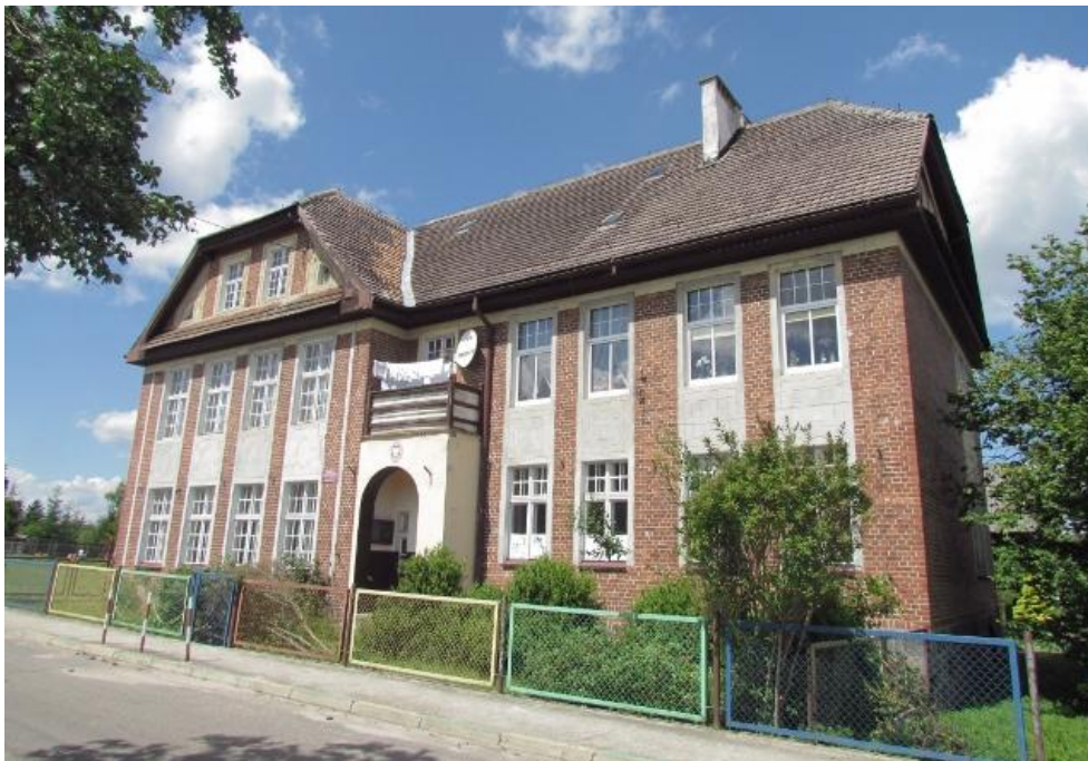
Fot. 1 Widok od strony drogi
