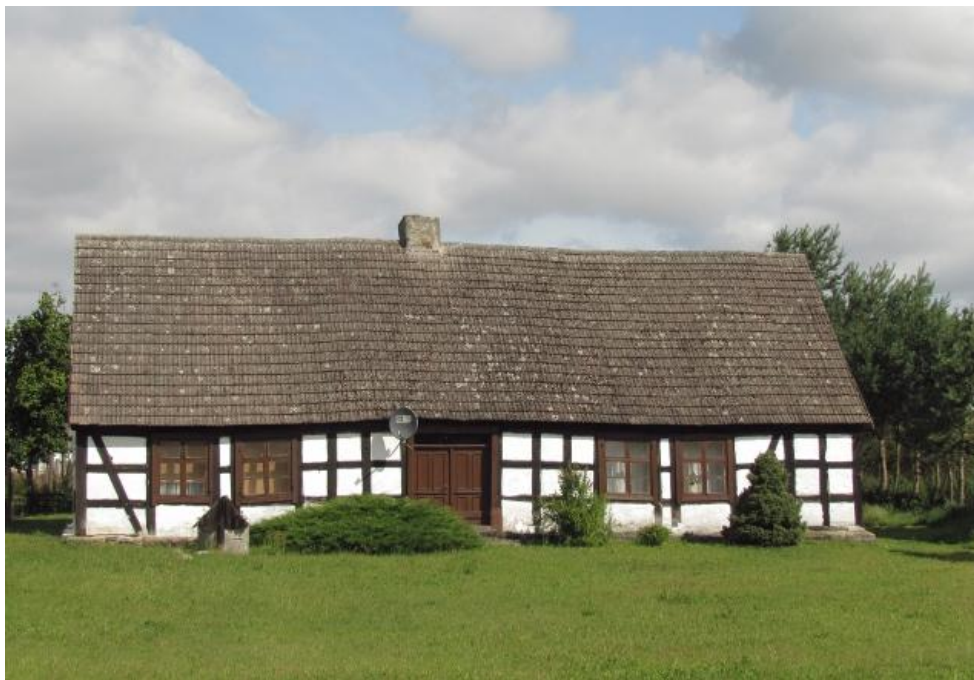
Fot. 1 Widok od frontu
