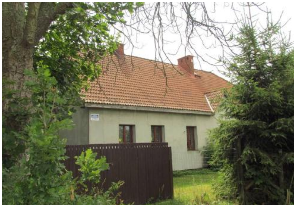
Fot. 1 Widok od strony drogi
