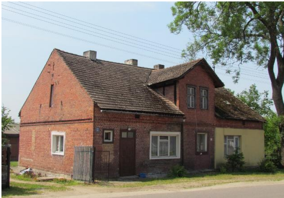
Fot. 1 Widok od strony frontowej
