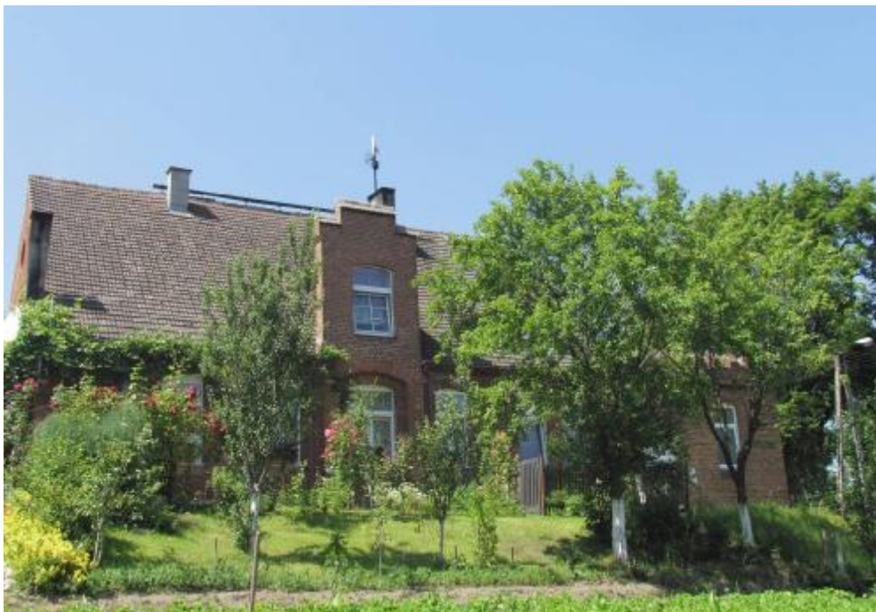
Fot. 1 Widok od strony drogi
