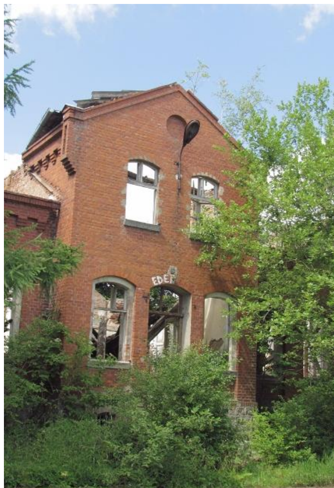
Fot. 2 Widok od strony frontowej
