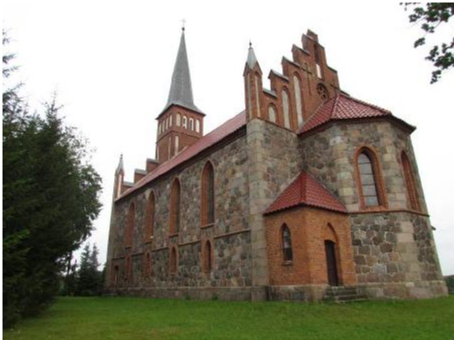
Fot. 1 Widok od tylnej strony kościoła
