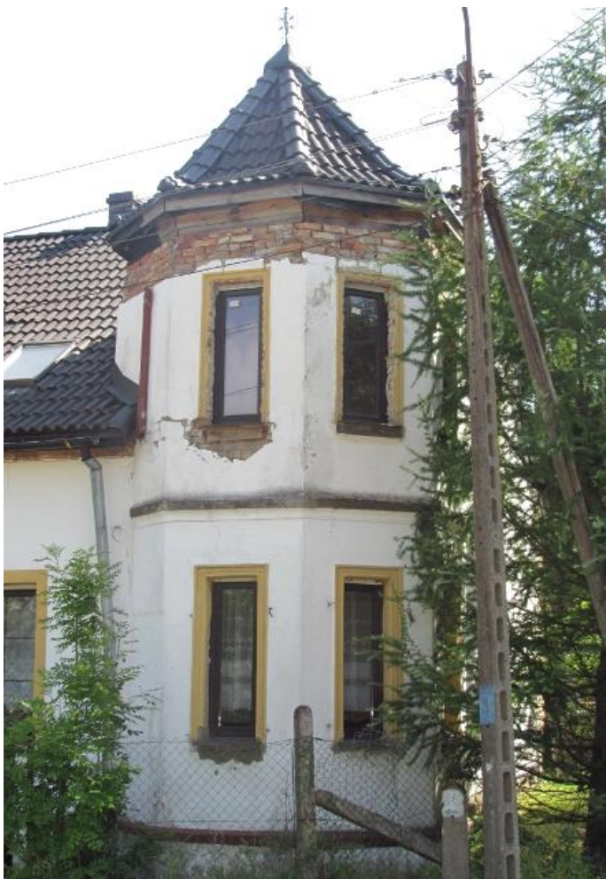
Fot. 1 Wieżyczka budynku
