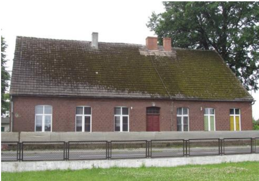
Fot. 1 Widok od strony drogi
