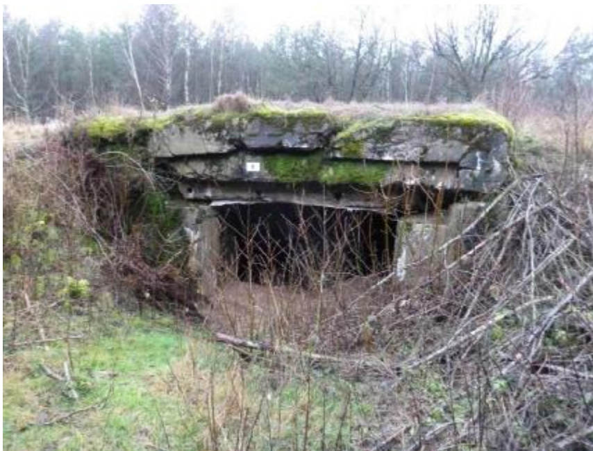
Fot. 1 Pozostałości schronu bojowego od strony wschodniej
