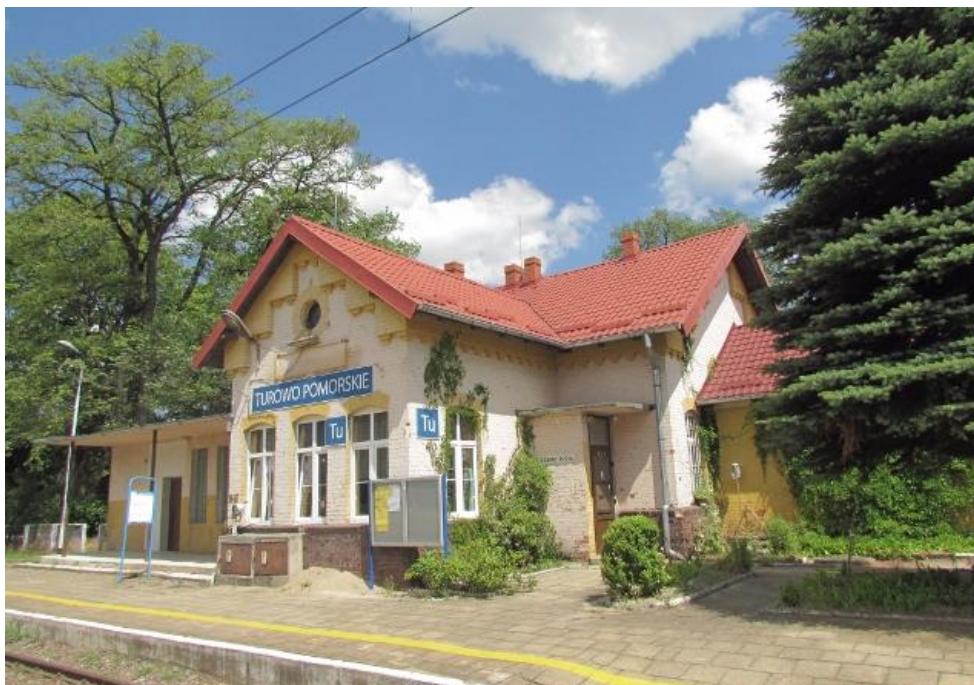
Fot. 1 Budynek dworca
