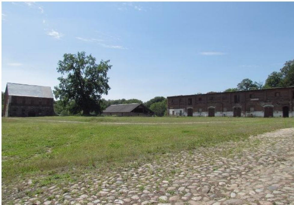
Fot. 1 Pozostałości zespołu folwarcznego
