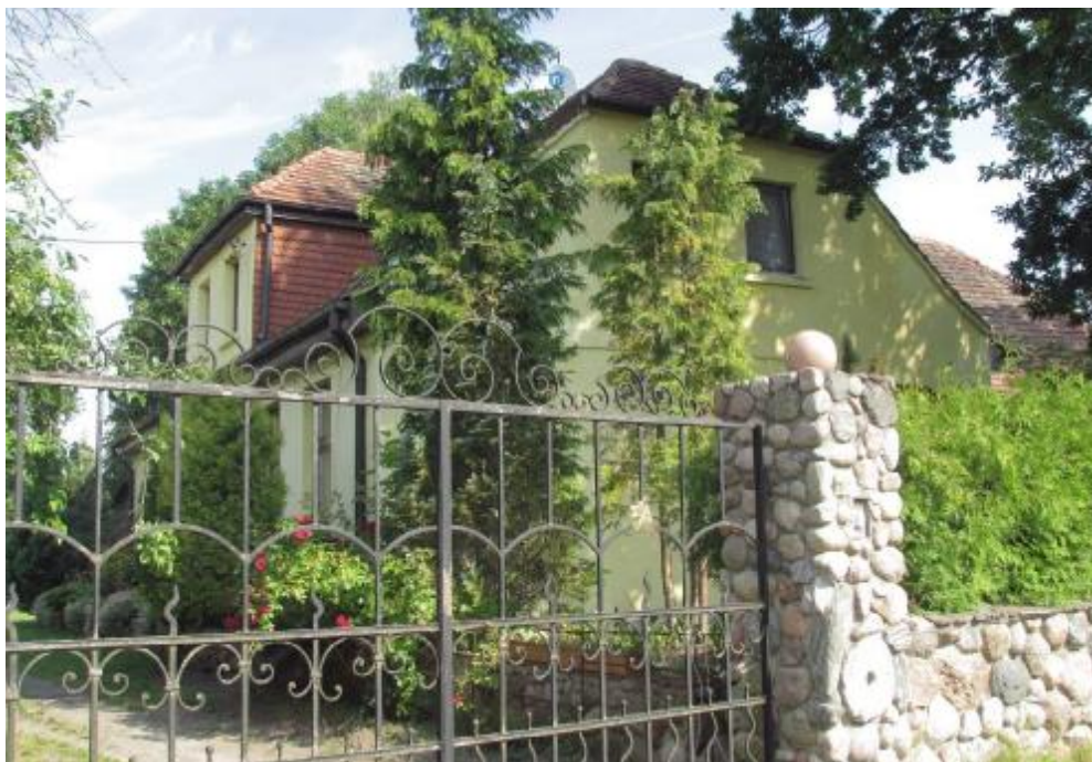
Fot. 1 Widok od strony drogi
