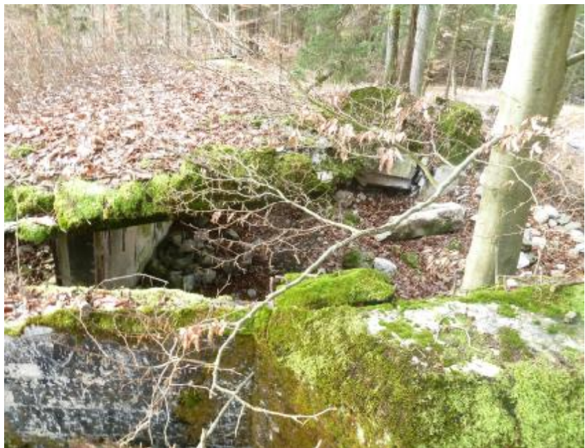
Fot. 1 Pozostałości schronu bojowo-biernego
