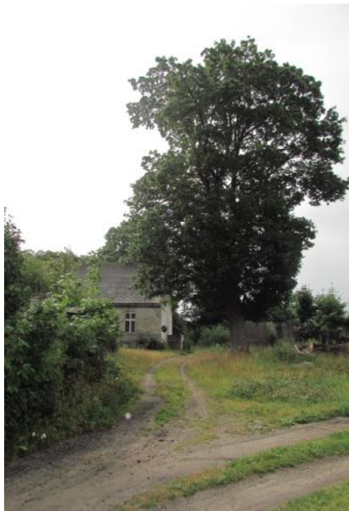
Fot. 2 Widok od strony drogi dojazdowej
