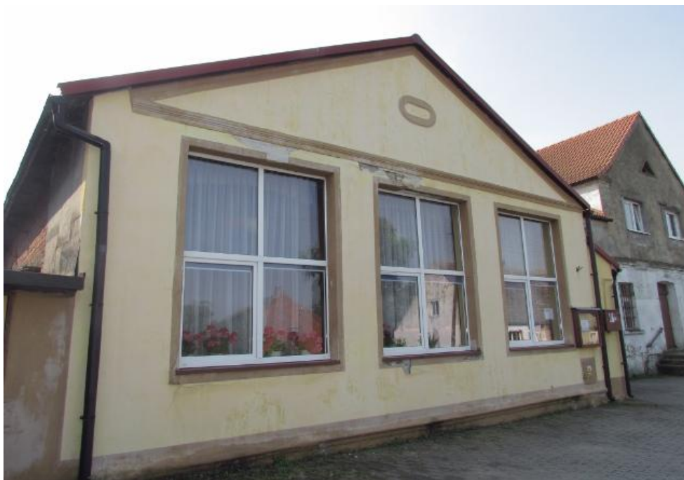
Fot. 1 Widok od strony frontowej
