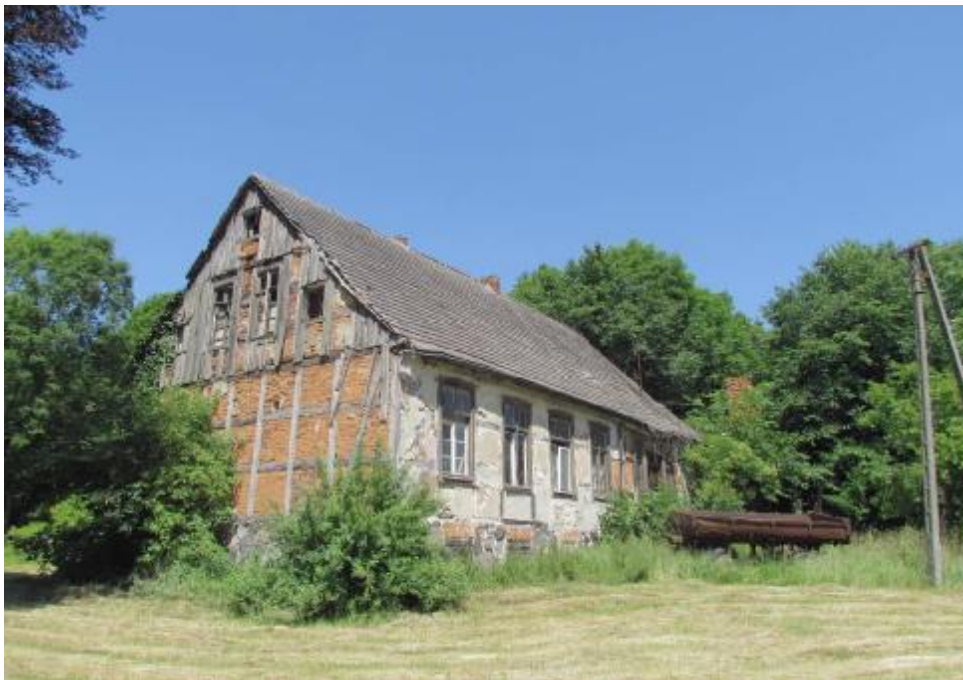
Fot. 1 Widok od strony frontowej
