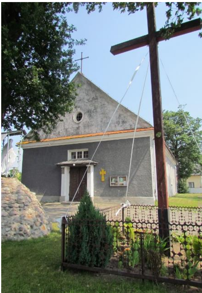
Fot. 1 Widok od strony wejścia do kościoła
