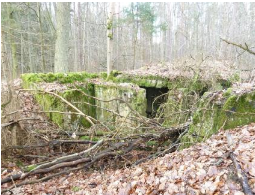
Fot. 2 Pozostałości schronu bojowo-biernego
