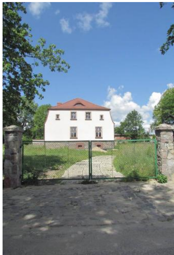
Fot. 2 Widok od strony drogi
