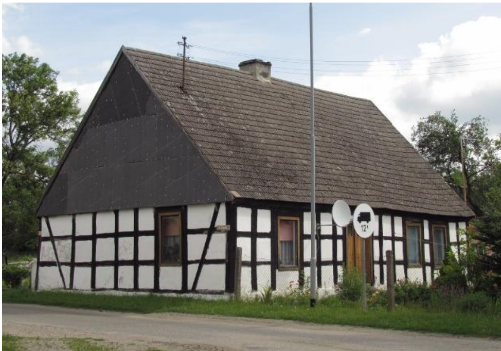
Fot. 1 Widok od strony drogi
