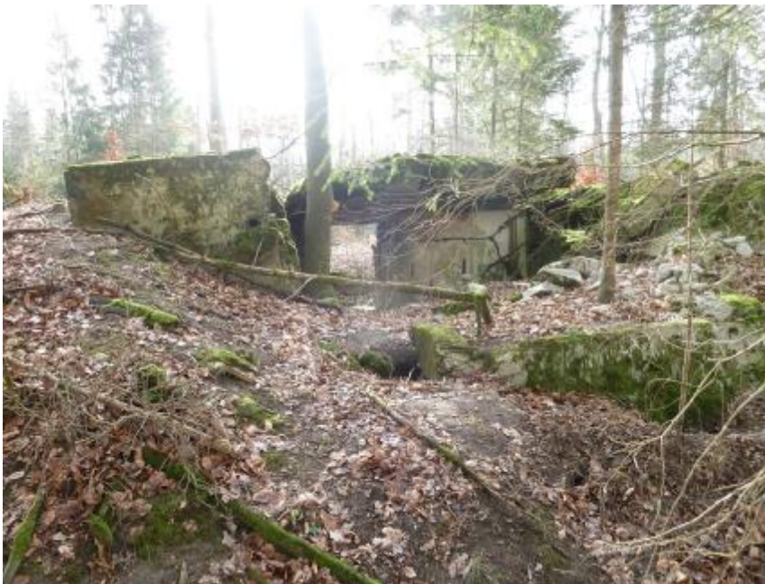
Fot. 2 Pozostałości schronu bojowo-biernego
