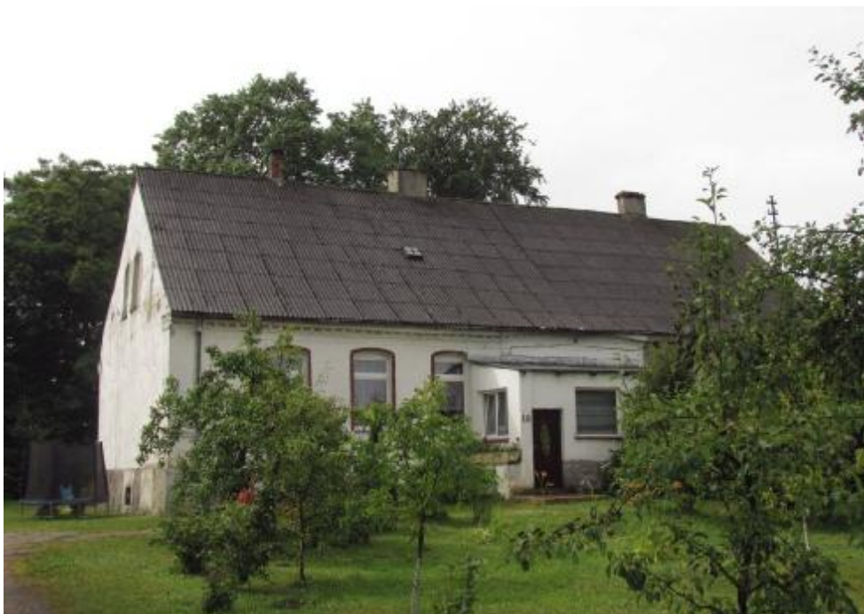
Fot. 1 Widok od strony drogi dojazdowej
