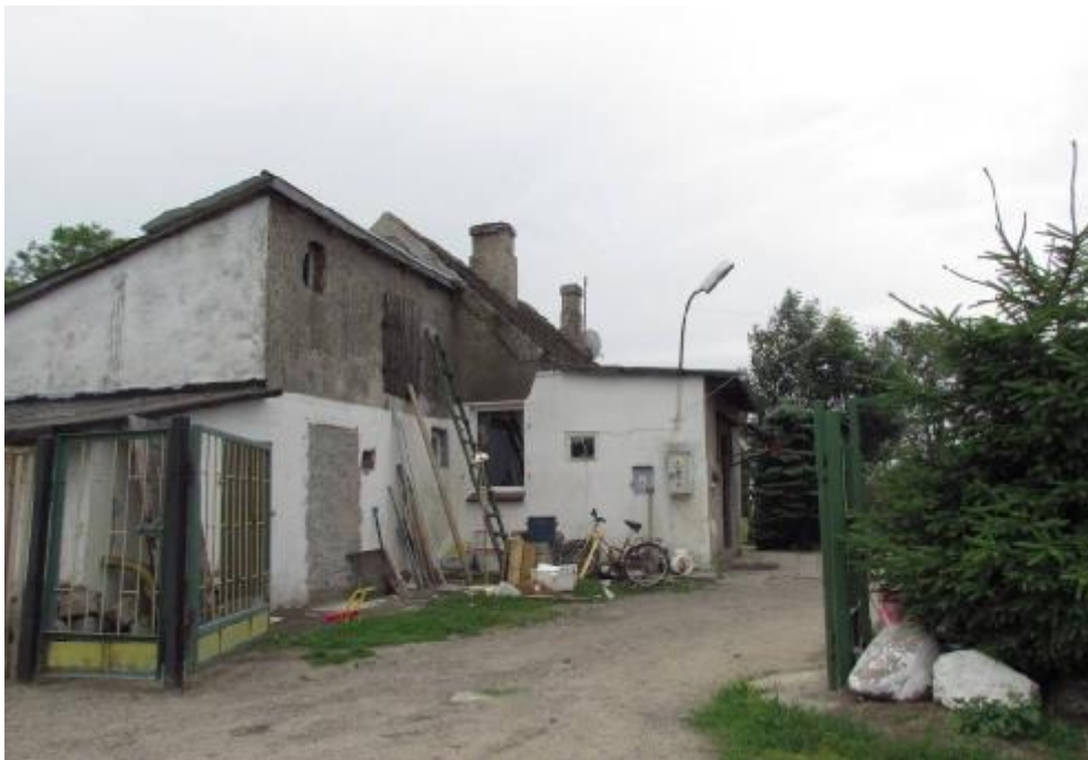
Fot. 1 Zabudowa stacjkolejowej
