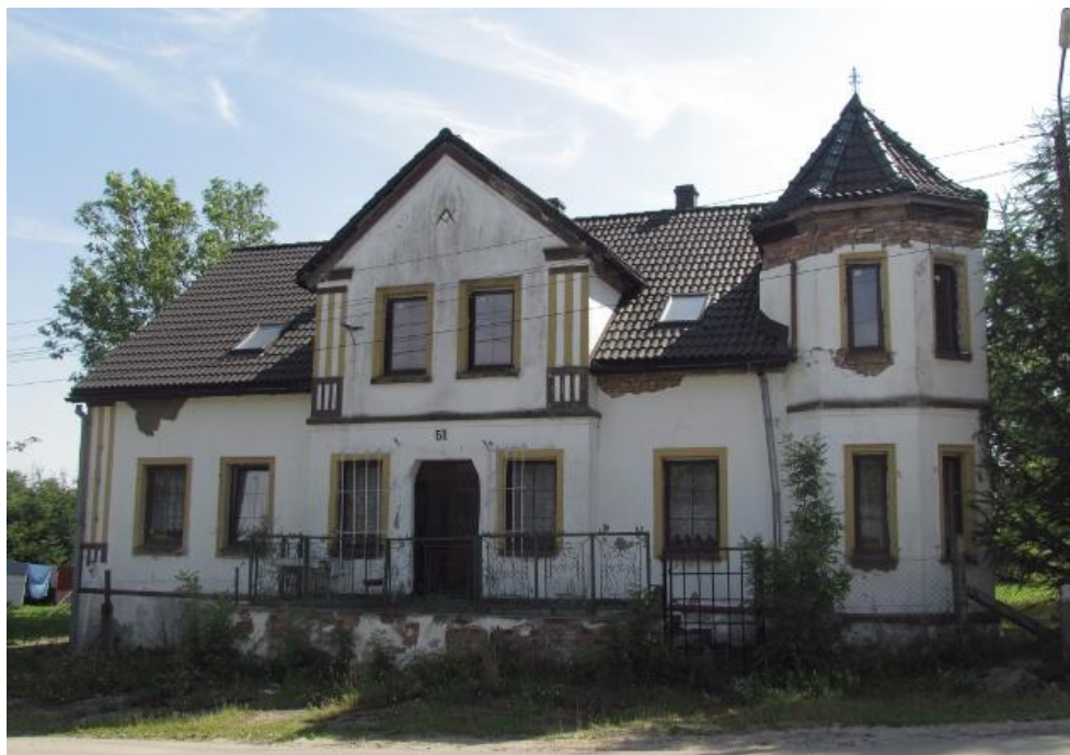
Fot. 2 Widok od strony frontowej
