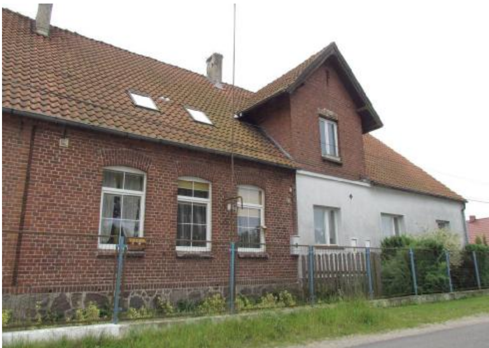
Fot. 1 Widok od strony drogi
