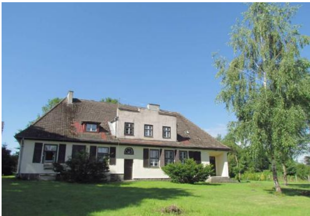
Fot. 1 Widok od strony drogi
