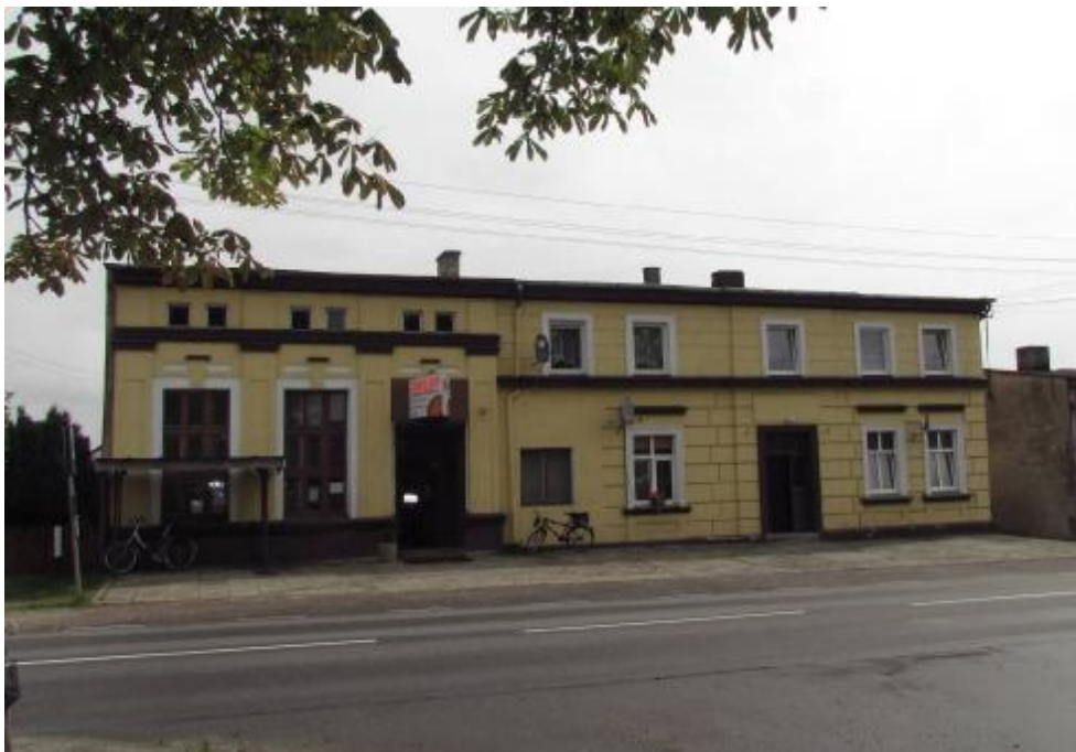
Fot. 1 Widok na świetlicę od strony drogi
