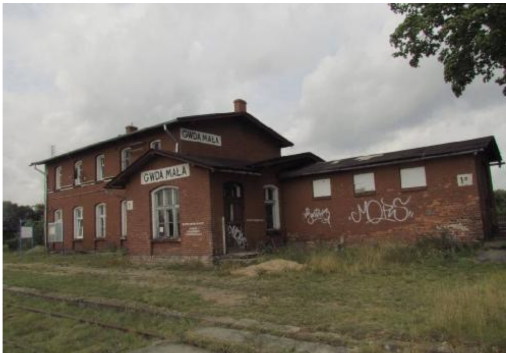
Fot. 1 Dworzec kolejowy
