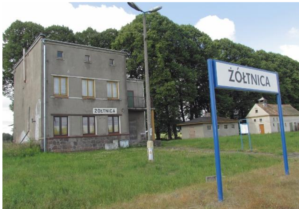
Fot. 1 Widok od strony orów kolejowych
