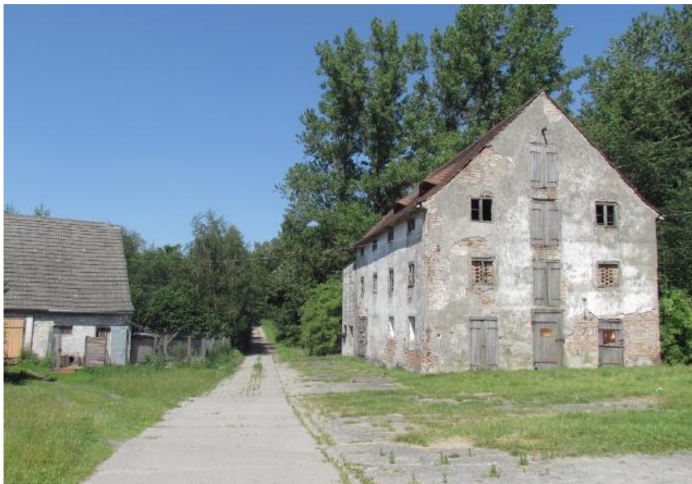
Fot. 1 Pozostałości zespołu folwarcznego
