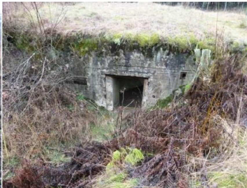
Fot. 2 Pozostałości schronu bojowego od strony zachodniej
