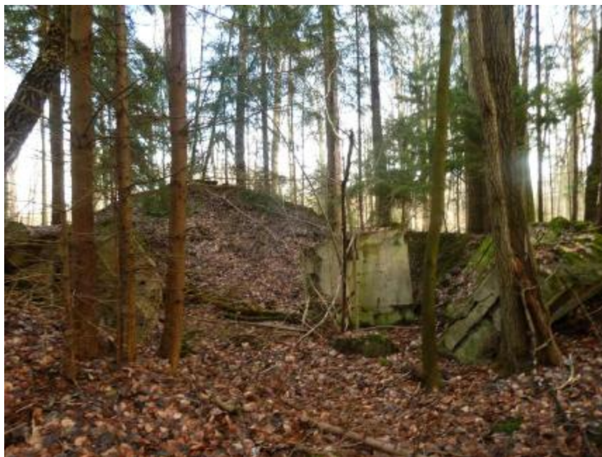
Fot. 1 Pozostałości schronu bojowo-biernego
