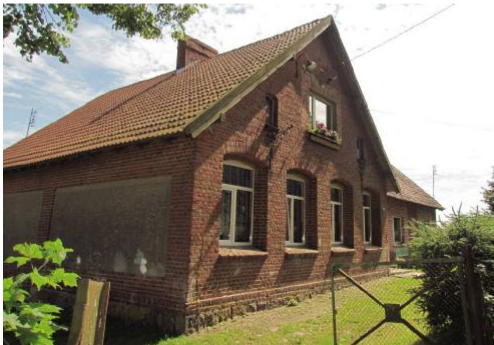
Fot. 1 Widok od strony drogi
