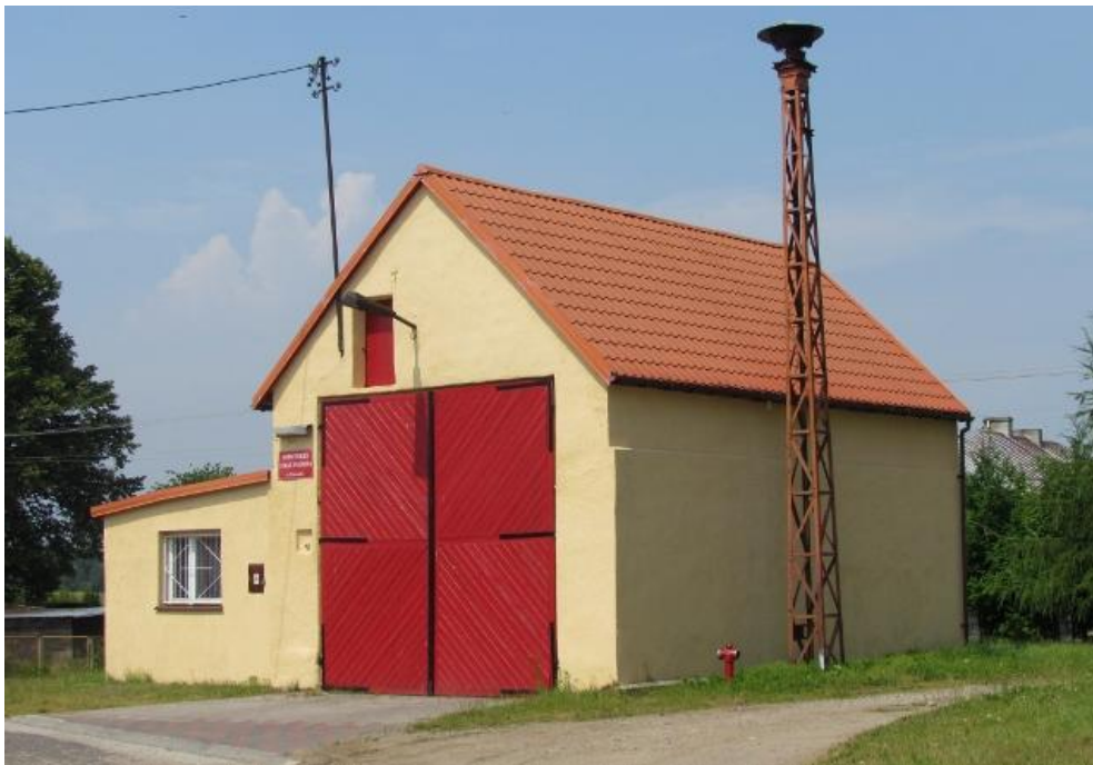
Fot. 1 Widok od strony wjazdowe
