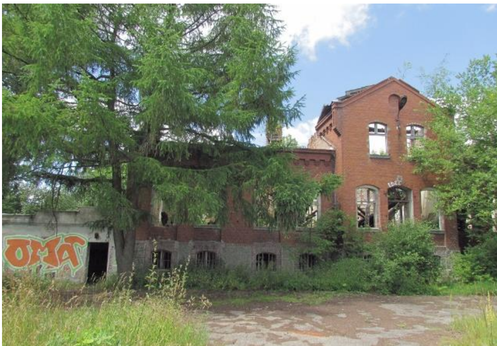
Fot. 1 Widok od strony frontowej
