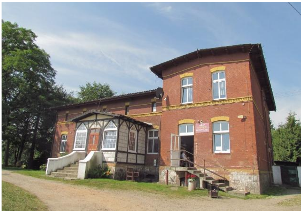
Fot. 1 Widok od frontu
