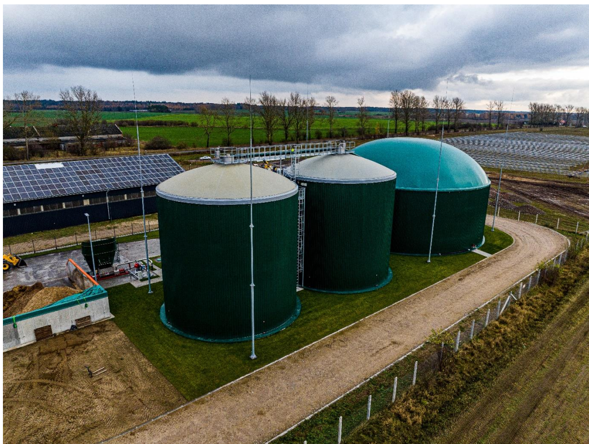
Ryc. 1 Istniejąca biogazownia o mocy 0,5 MW w Turowie
