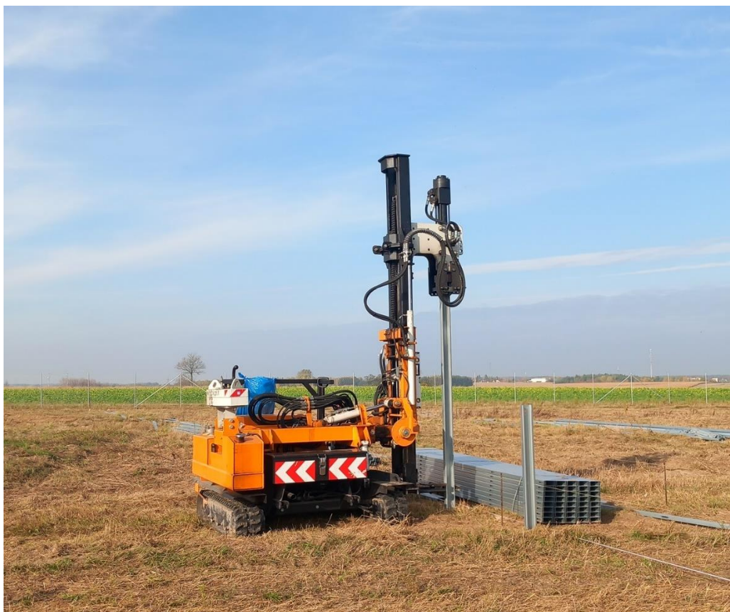
Fot. 7.2.1-1: Montaż pionowych profili wbijanych w ziemię za pomocą kafara
