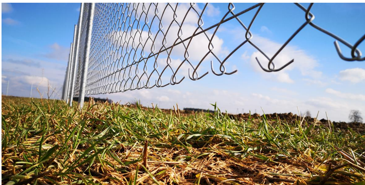
Fot. 7.7.2-2: Przykładowe ogrodzenie farmy fotowoltaicznej, widoczna przerwa pod ogrodzeniem umożliwiająca migrację drobnej fauny.
