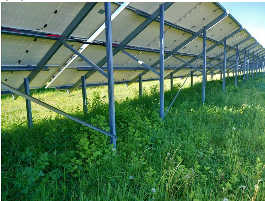
Fot. 3.2.1-1: Panele jednostronne na farmie fotowoltaicznej, pod panelami widoczna wegetacja (farma w miejscowości Ciechanowiec, woj. podlaskie)
