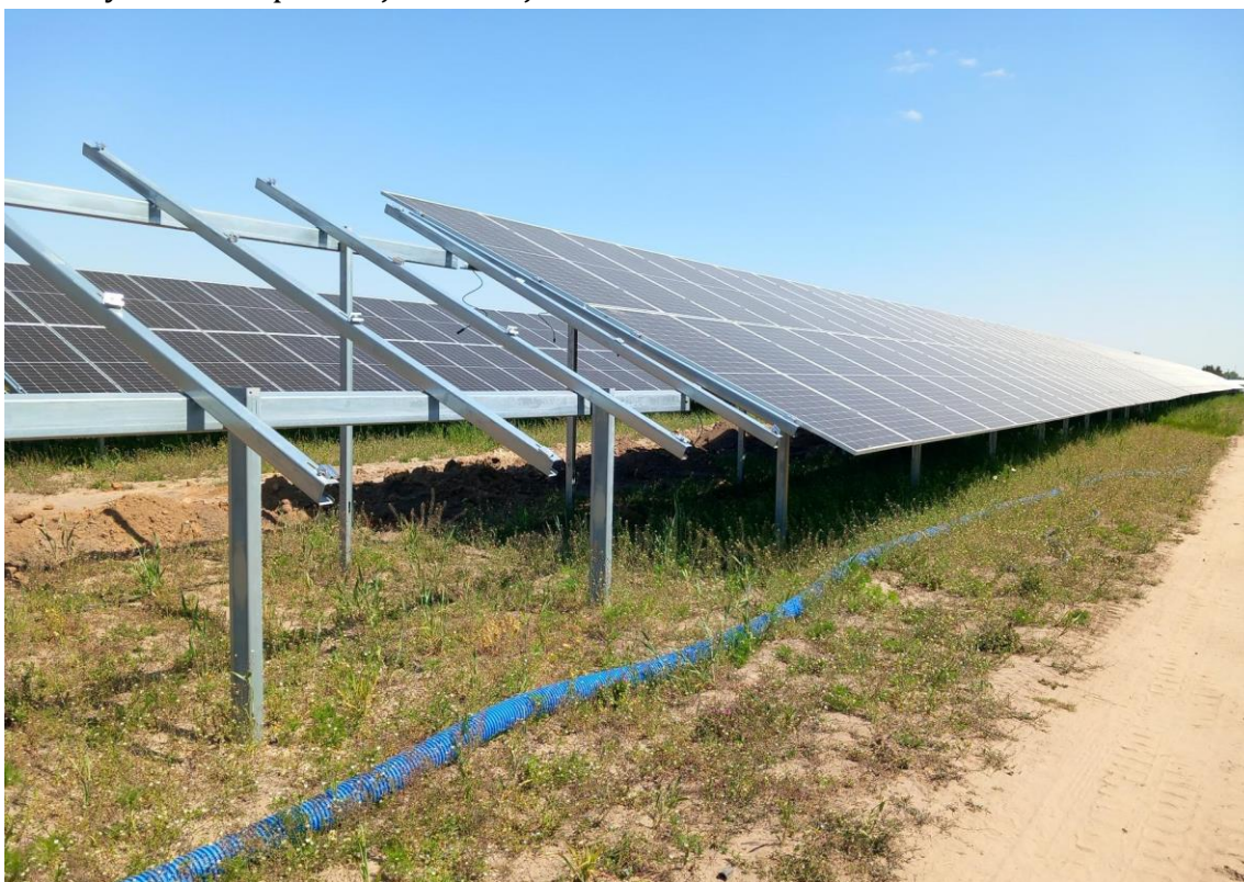
Fot. 3-1: Przykładowa konstrukcja stołu z modułami fotowoltaicznymi na budowanej farmie fotowoltaicznej (miejscowość Wdziękoń Drugi, woj. podlaskie)
