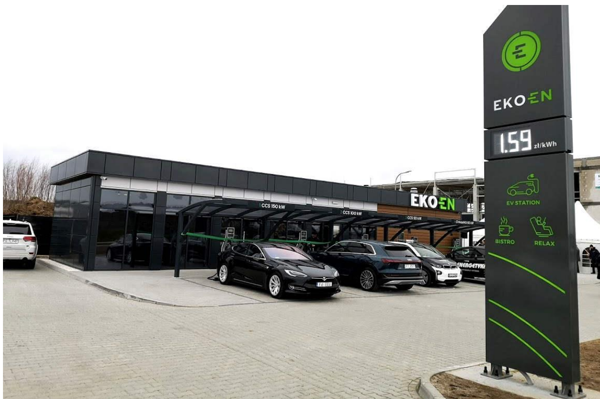
Rysunek 21 Przykładowa stacja ładowania pojazdów EV w Zielonej Górze należąca do Ekoenergetyka Polska.
