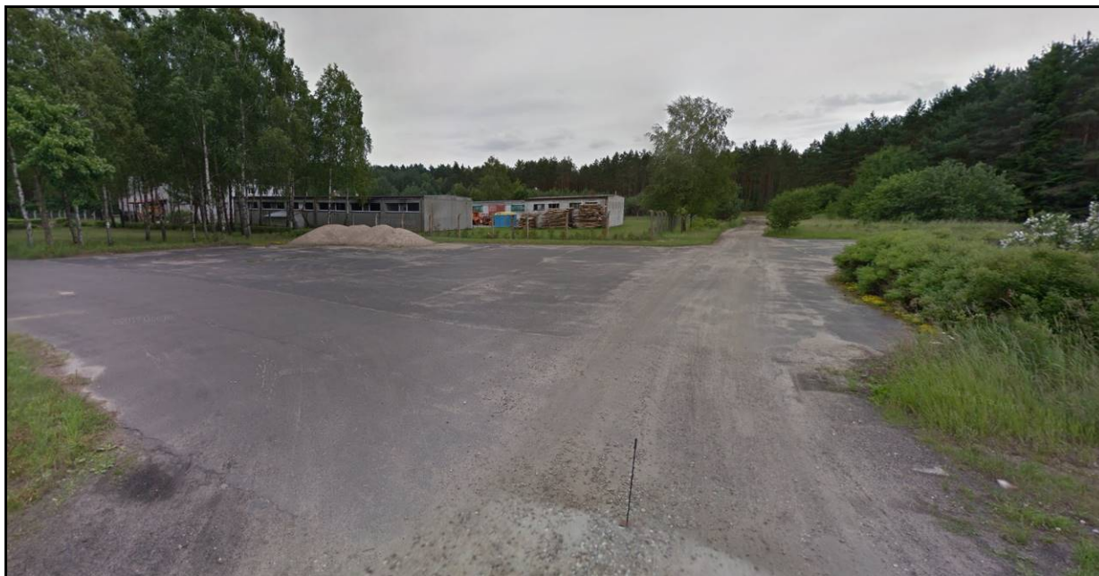
Fotografia 1. Teren objęty planowaną inwestycją – widok na budynki, gdzie będą funkcjonować linie technologiczne.
